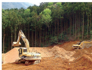
採掘後の山に赤土、土砂などを搬入
